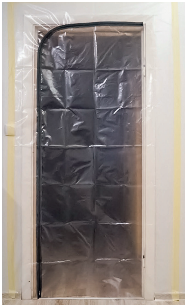
Dammskyddet ger en tät anslutning mot rum som renoveras.
